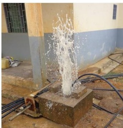
Installazione nuova pompa elettrica nel pozzo
